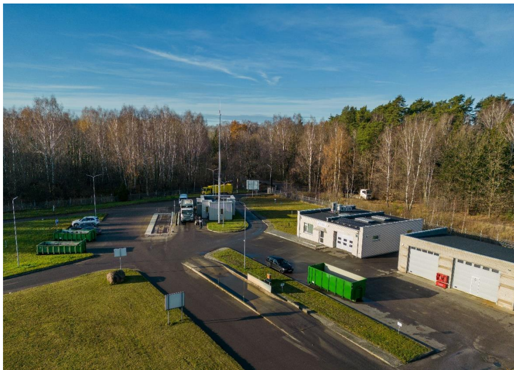
20 pav. Panevėžio regioninis sąvartynas
