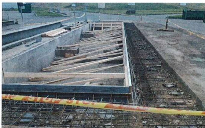
28 pav. Automobilinių svarstyklių pamatų remonto darbai
