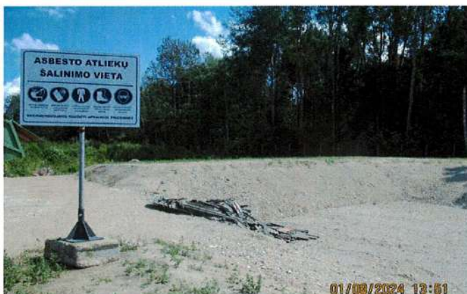
26 pav. Asbesto turinčių atliekų šalinimo sekcija
