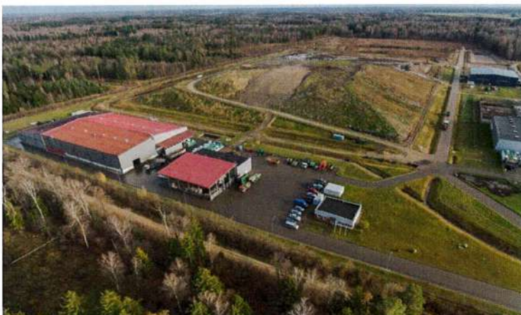
19 pav. Panevėžio regioninis sąvartynas
