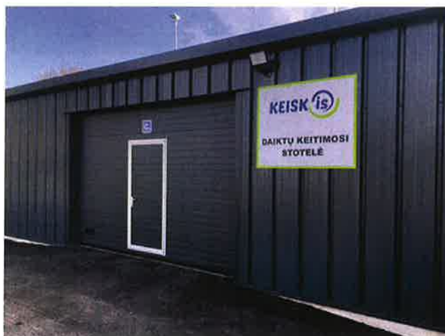
31 pav. Kėdainių g. 13;15, Panevėžys, įrengta DGASA
