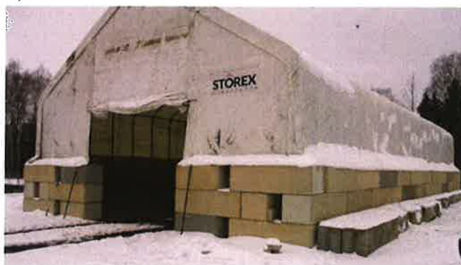
24 pav. Tentinis angaras komposto sandėliavimui
