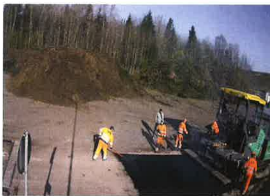
23 pav. Kelio remontas sąvartyno teritorijoje
