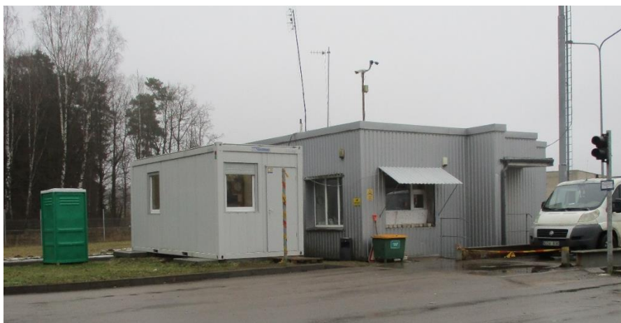
32 pav. Konteinerinės patalpos
