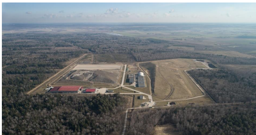
23 pav. Panevėžio regioninis sąvartynas
