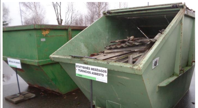
10 pav. Statybinių medžiagų, turinčių asbesto atliekos
