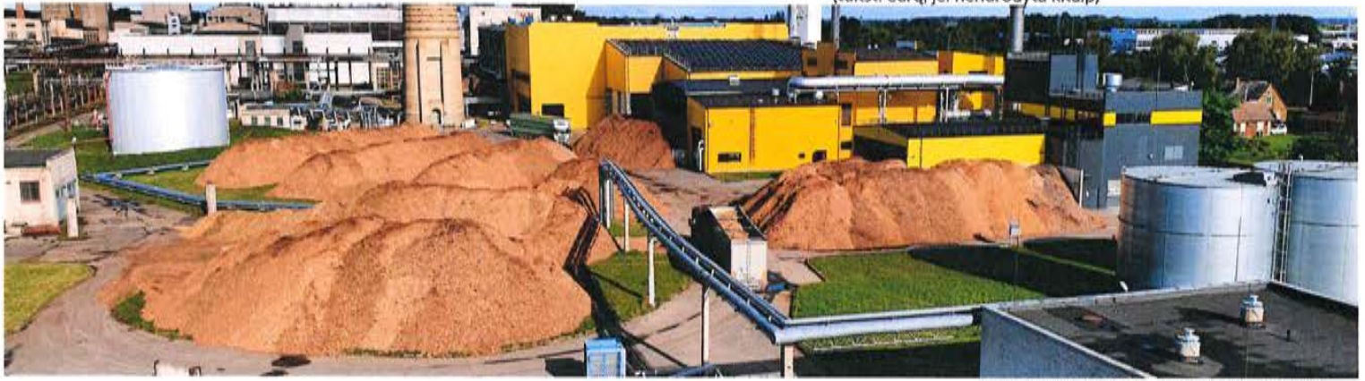
(Panevėžio RK-1, adresu Pušaloto g. 191, Panevėžys)
