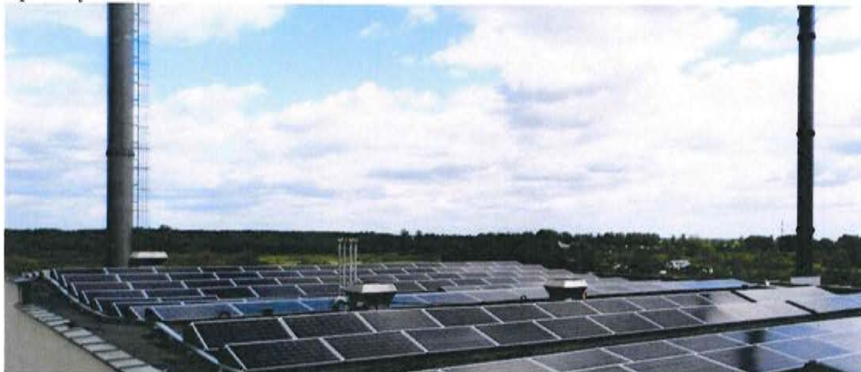
(Saulės fotovoltinė elektrinė esanti adresu Pušaloto g. 191, Panevėžys)
