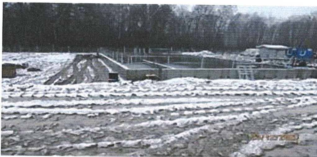
26 pav. Naujai statomas sąvartyno nuotekų surinkimo rezervuaras
