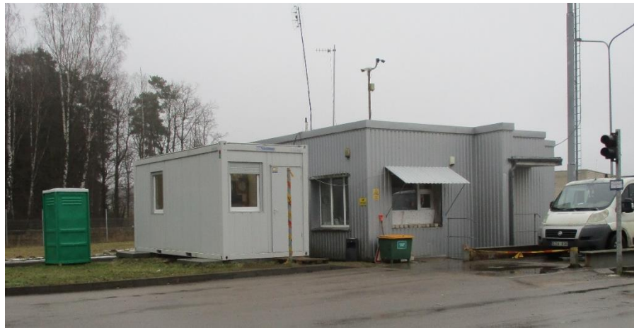
32 pav. Konteinerinės patalpos
