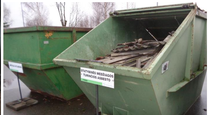
10 pav. Statybinių medžiagų, turinčių asbesto atliekos
