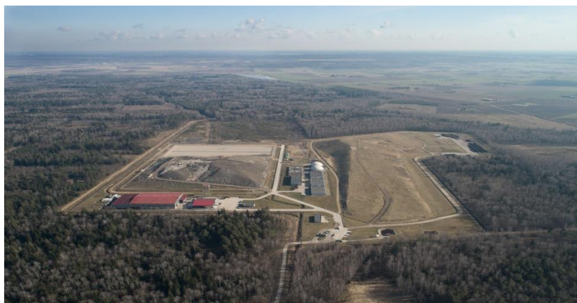
23 pav. Panevėžio regioninis sąvartynas
