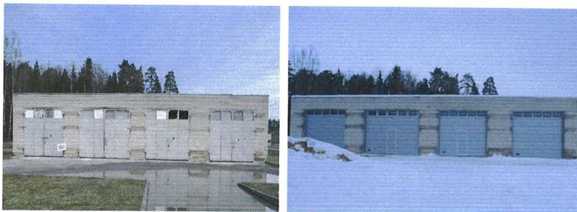
29-30 pav. Sandėlis-garažas (vartai prieš ir po remonto)
