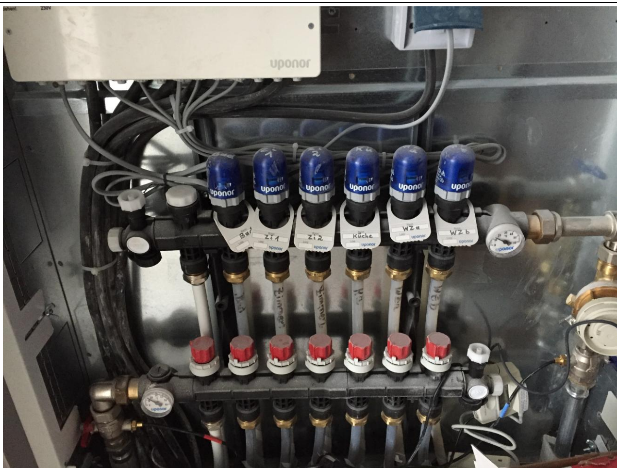
12 pav.: Grindų šildymo sistemos išankstinis reguliavimas© ZEBAU
