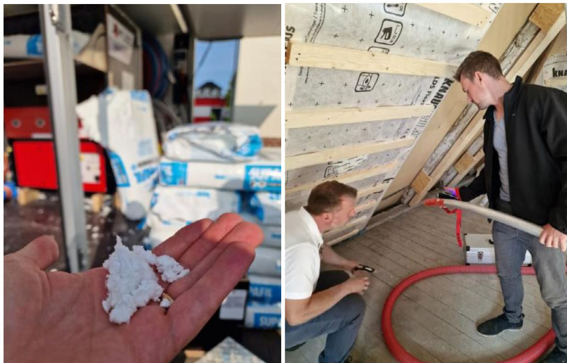
3 pav.: Įpučiamos izoliacijos įrengimas © ZEBAU GmbH
