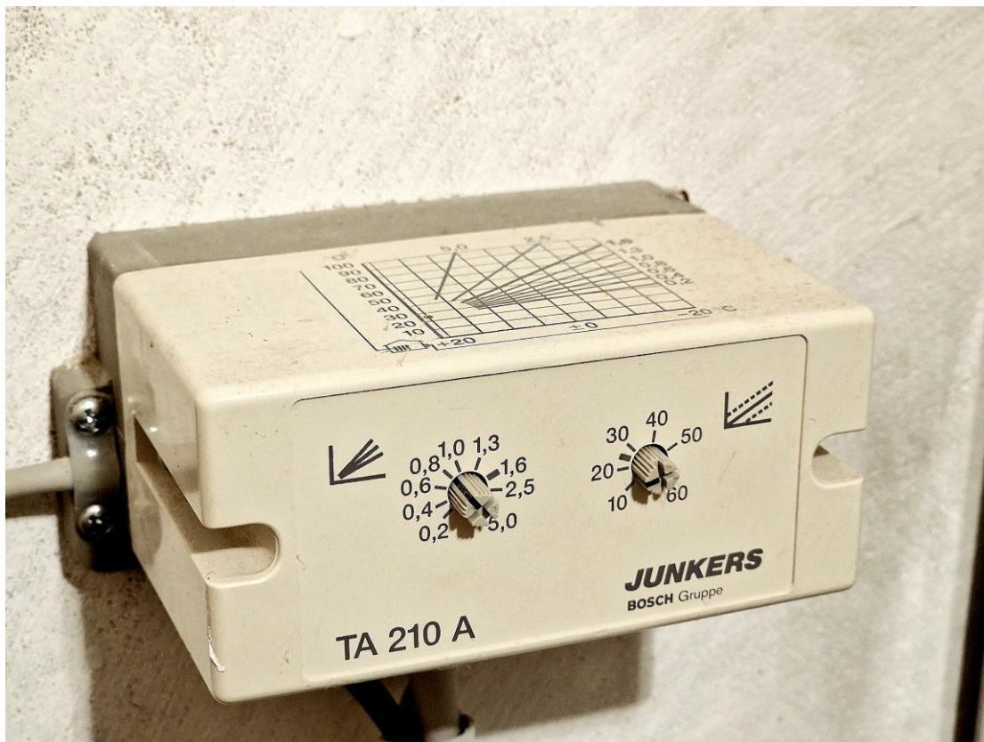
13 pav.: Valdymas pagal lauko temperatūrą © ZEBAU GmbH
