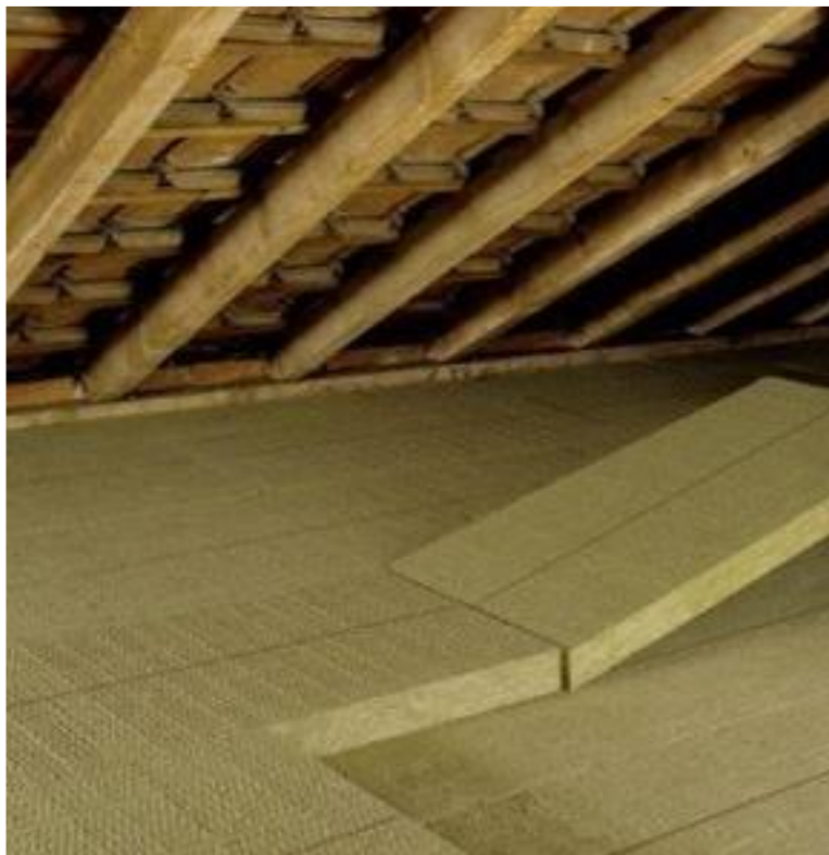
1 pav.: Viršutinio aukšto apšiltinimo pavyzdys © ZEBAU GmbH
