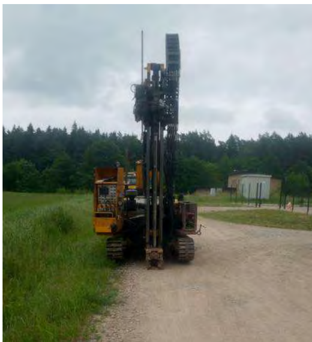
1 pav. Lauko darbai
