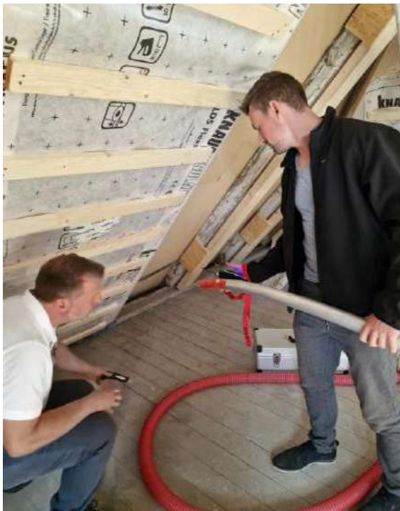
3 pav.: Įpučiamos izoliacijos įrengimas © ZEBAU GmbH
