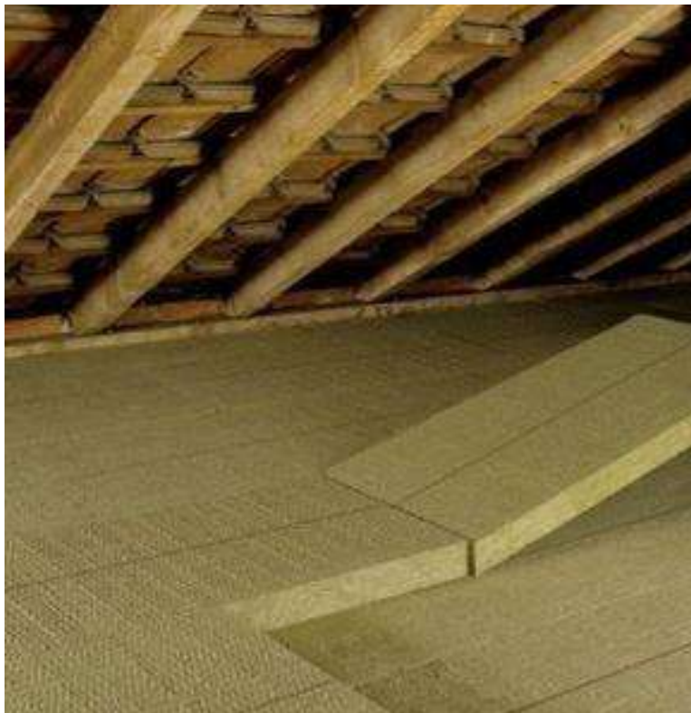
1 pav.: Viršutinio aukšto apšiltinimo pavyzdys © ZEBAU GmbH
