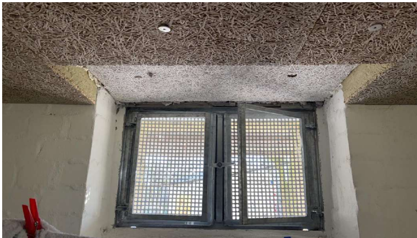
2 pav.: Izoliuotos rūšio lubos © ZEBAU GmbH
