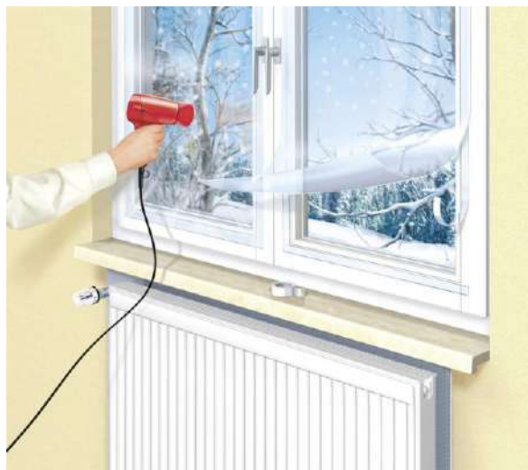
7 pav.: Paruošiamieji langų plėvelės montavimo darbai © Freepik ( www.freepik.com ) 8 pav.: © PHI
