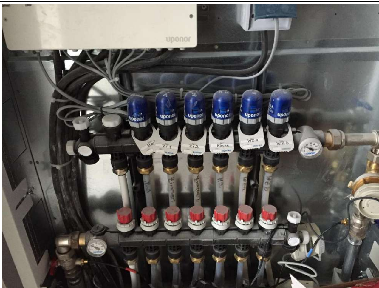
13 pav.: Grindų šildymo sistemos išankstinis reguliavimas© ZEBAU
